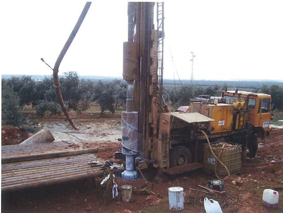
Foto nº 2. Labores de reperforación del sondeo Algaidlla III, en Estepa (Sevilla)
